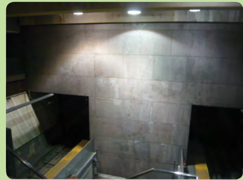
La ubicación potencial para el nuevo ascensor.
