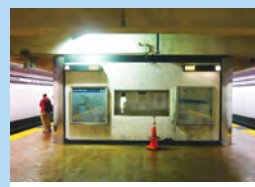
Reparar las baldosas, mejorar las visualizaciones y aumentar la iluminación general de las plataformas
