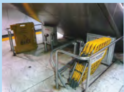
增設月台儲藏空間
