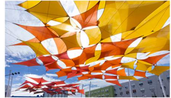
ESTRUCTURA DE SOMBREADO
